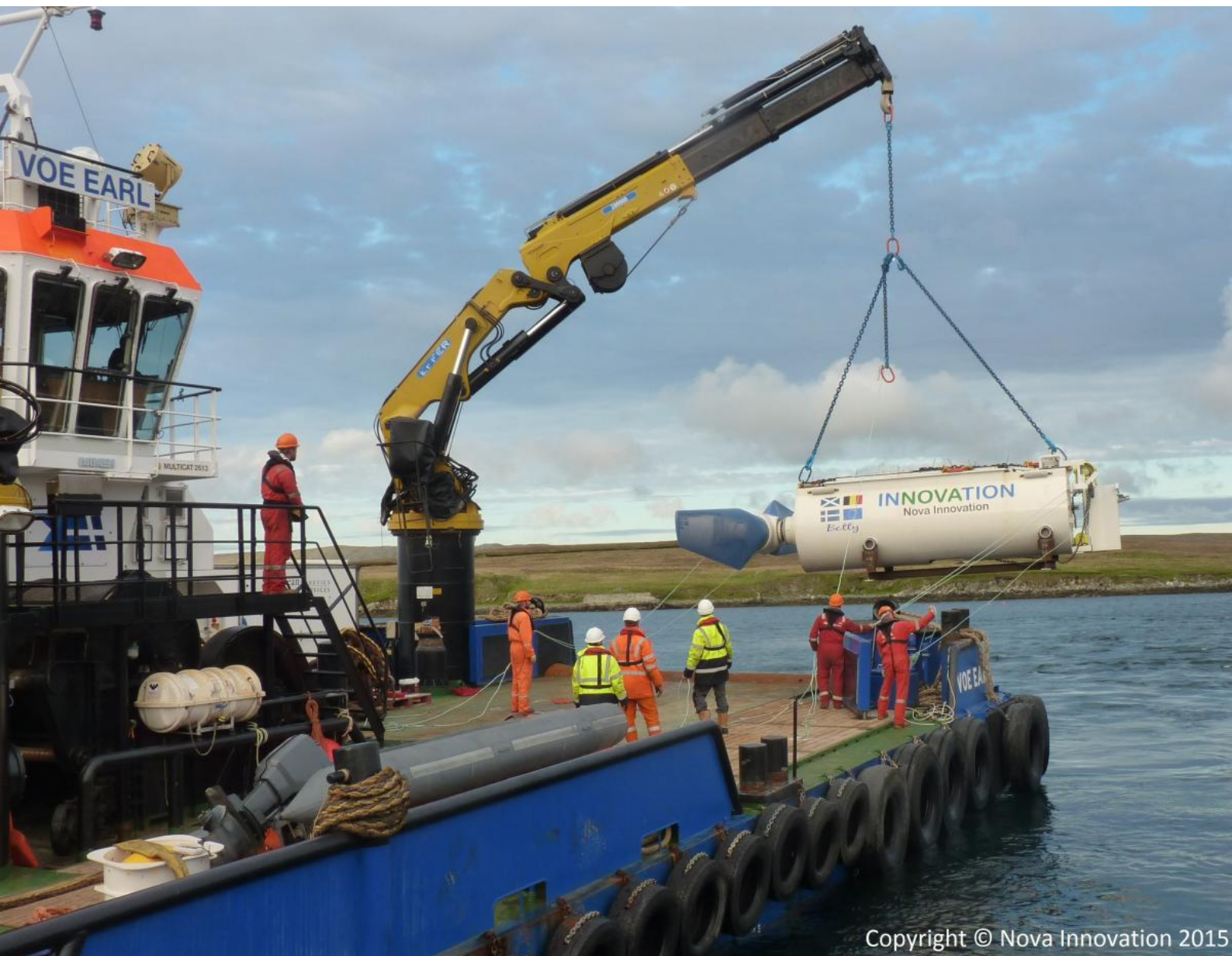
Déploiement d'une hydrolienne sur le site Bluemull Sound, à proximité des îles Shetlands, par l'Agence IDETA et ses partenaires.
